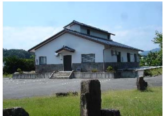
・西条地区農業集落排水処理施設
