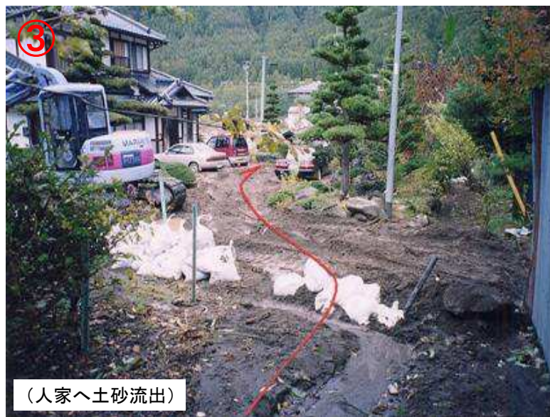
施工前(平成16年10月)
