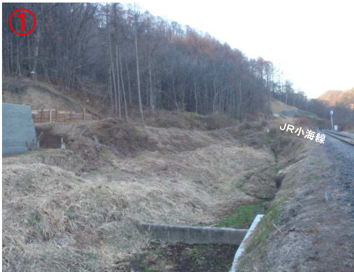
施工前(平成24年11月)
