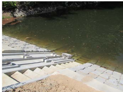
施工後の斜樋：管理用の階段を設置 堤頂からの巻上方式
