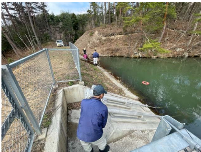
斜樋 動作確認
