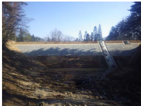
洪水吐の改修 取水施設改修
