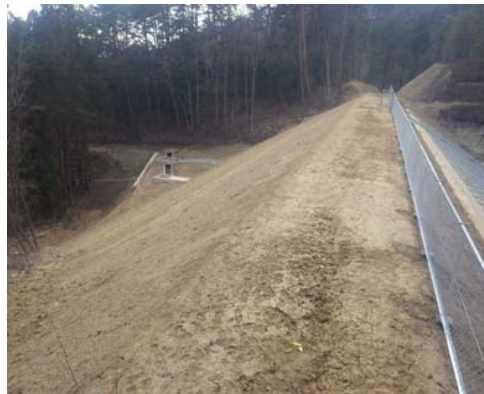
施工後の斜樋：管理用の階段を設置 堤頂からの巻上方式
