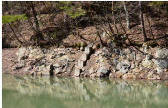
従前の斜樋：階段もなく、チェーン 引上げ方式で管理
