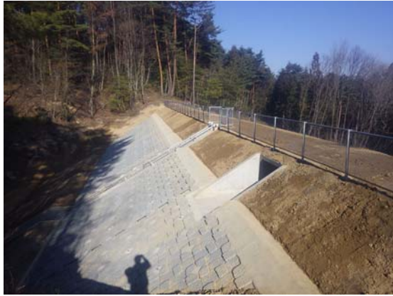
堤体上流側 波除護岸
