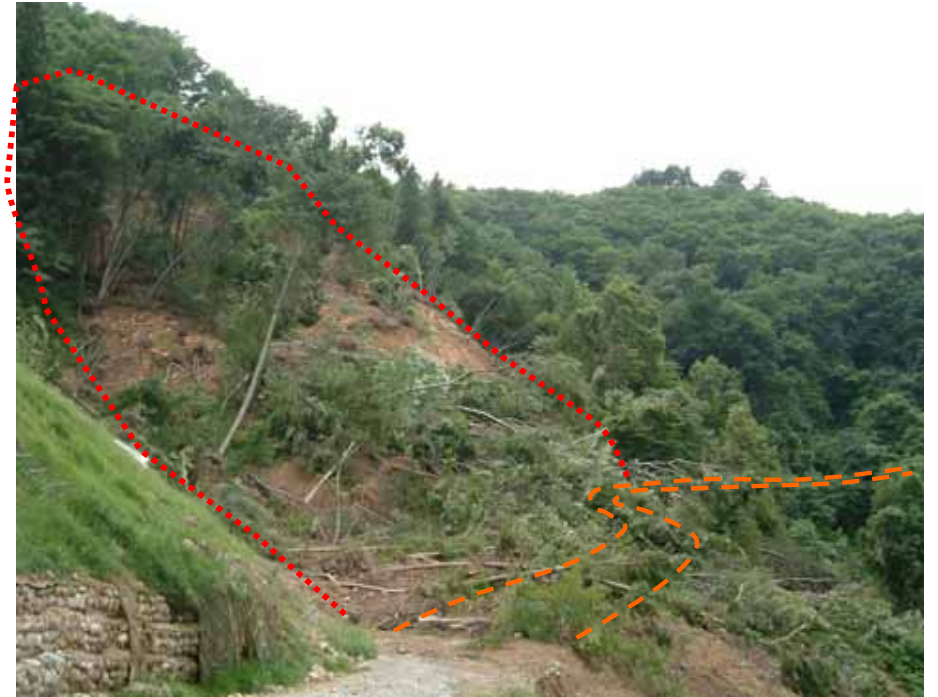
【事業実施前の状況】
