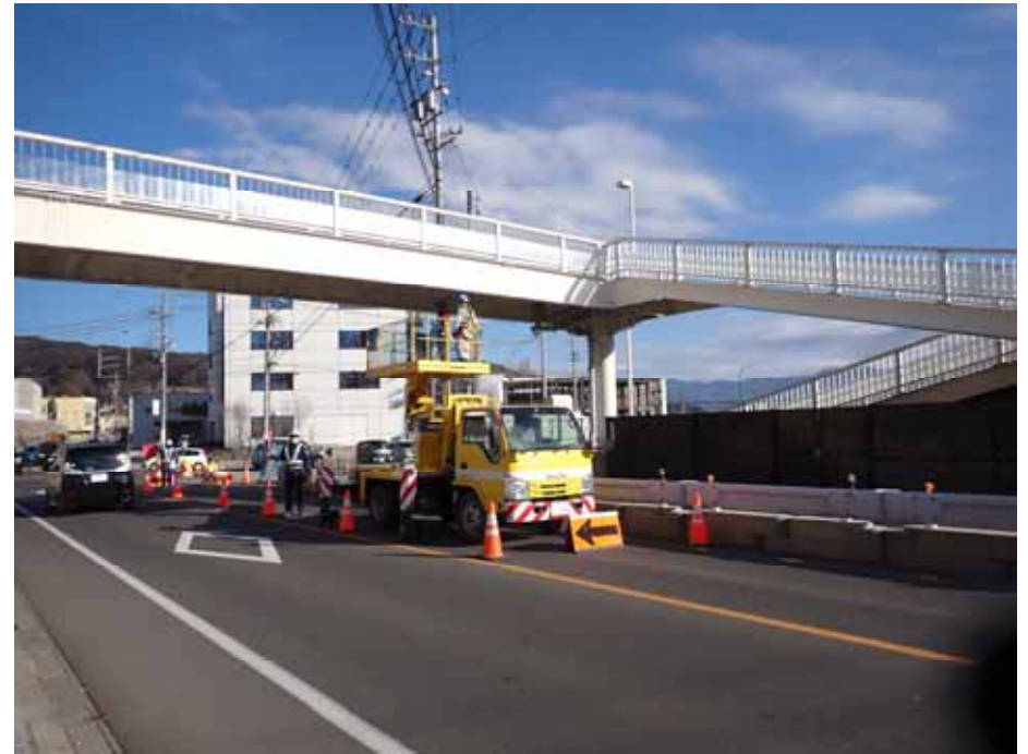
整備した歩道橋の定期点検
