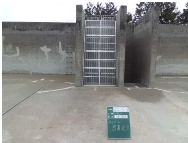
揚水機場調整池の補修
