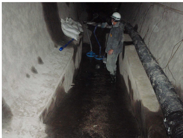
隧道内での補修作業
