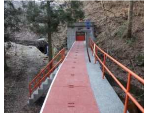
【押出原水路橋】
