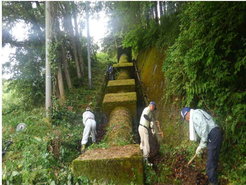
サイホン（暗渠管）周辺の清掃作業
