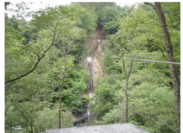
送水管アンカーブロックの補修 (架線の利用)
