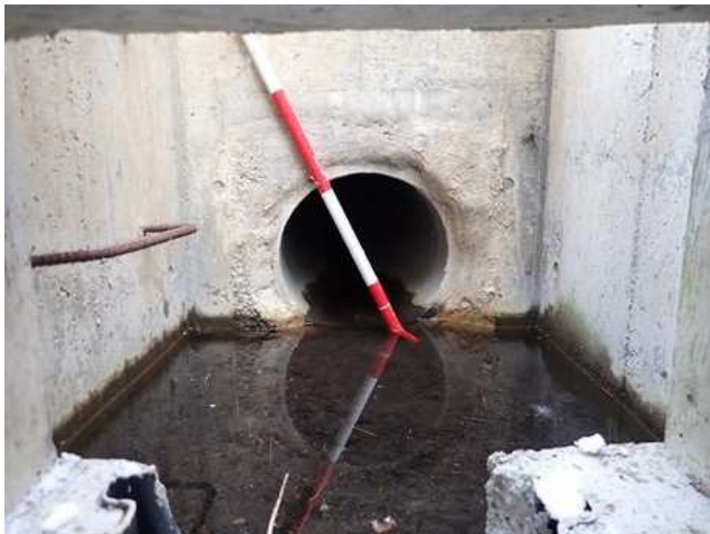
定期的な施設点検（排水施設）
