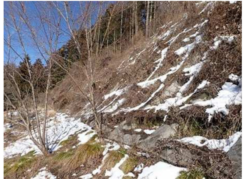
定期的な施設点検（法面）
