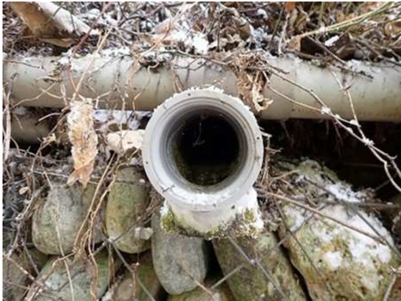
定期的な施設点検（地下水排水施設）
