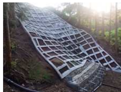
吹付法枠施工後
