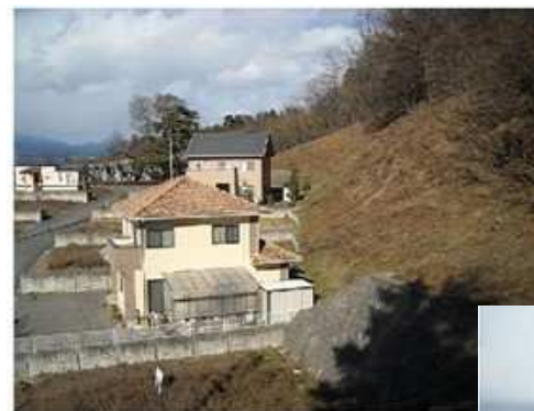
急傾斜地に隣接する人家
