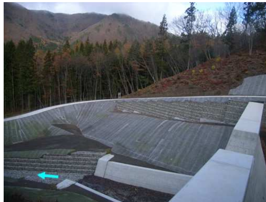
2号堰堤 (カゴ系構造物の採用及び緑化材の敷設)
