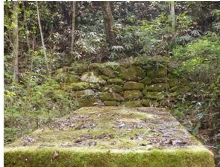
【現場発生材を使用した間詰工】
