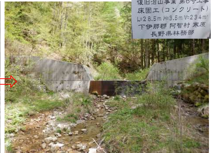
R6.5溪岸浸食等無く安定した溪流内
