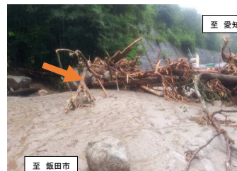
平成25年9月台風18号豪雨により 国道153号へ土砂流出 (飯田建設事務所による排土)
