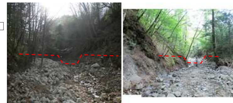
(No3床固工計画地付近) (No4床固工計画地付近) 溪流内の溪岸侵食及び不安定堆積土の状況
