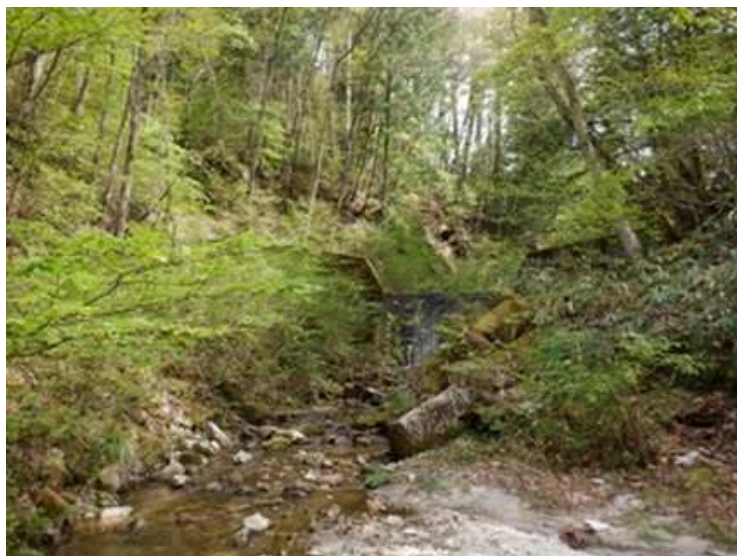
【自然になじんだ国道直上部のH25No1床固工】
