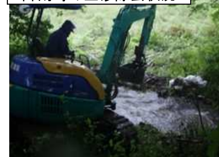
降雨時の土砂除去状況
