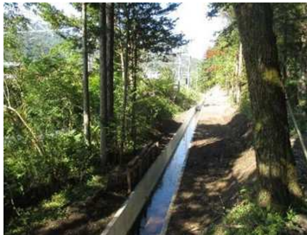
水路改修状況
