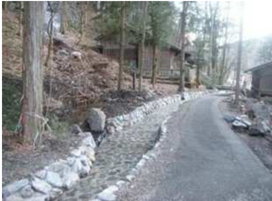
南宮神社内の水路改修
