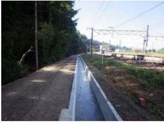
J R 線に隣接する水路改修
