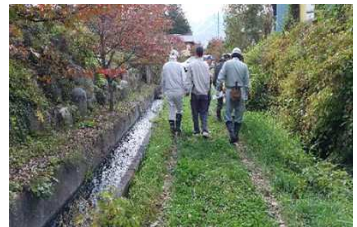
水路工事現場説明状況
