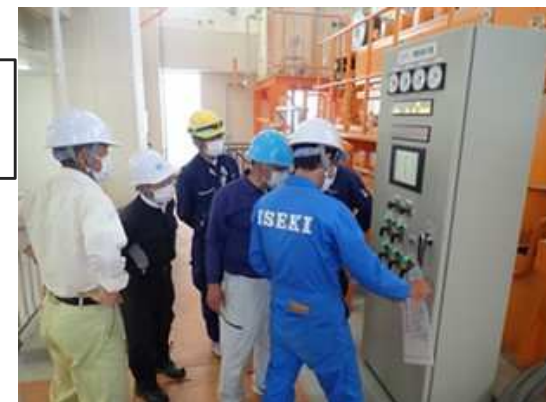
排水ポンプ 稼働確認
