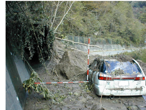
土砂崩落発生状況
