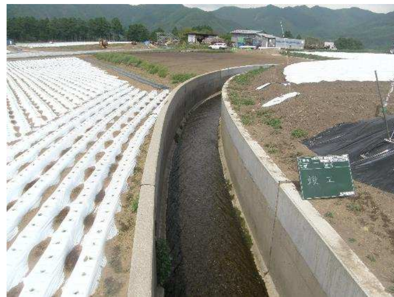
既設水路を使用し、断面不足分を嵩上げで対応
