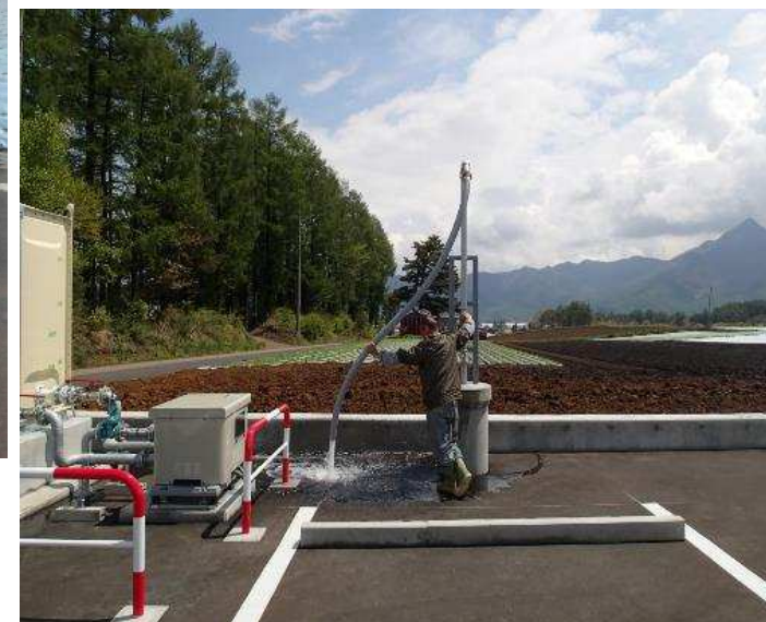
財産区による畑かん給水施設の点検、清掃
