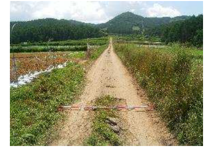
経年劣化から路面の損傷
