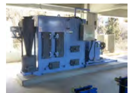
ペレットボイラー(伊那市)
