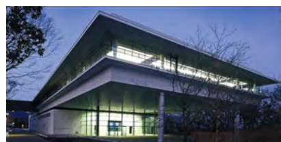
HIOKIイノベーションセンター (H27年4月竣工)
