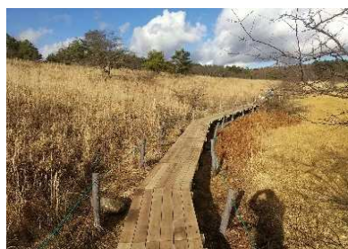
遊歩道の整備 七島・八島線道路(諏訪市)
