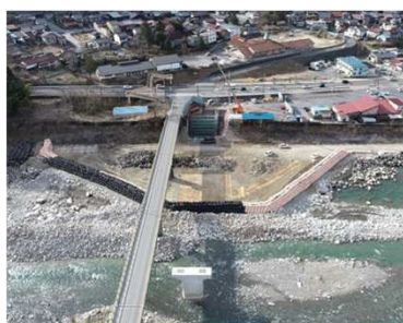
木曽川右岸道路
