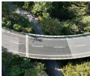
新唐沢橋 修繕工事
