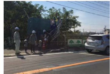
職域拡大イベント (橋梁工事現場見学会)
