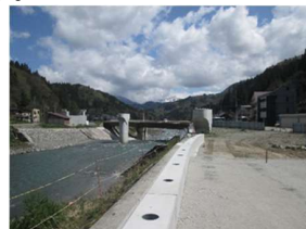
施工状況(2020年5月現在)
