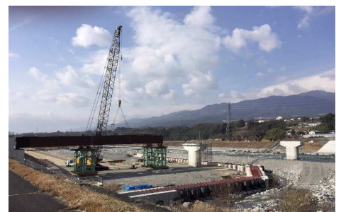
(主)伊那生田飯田線 松川町 宮ヶ瀬橋 (施工中 2019.1)
