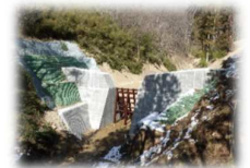
砂防堰堤（坂城町成久保）
