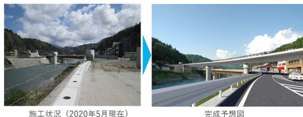
施工状況(2020年5月現在)
