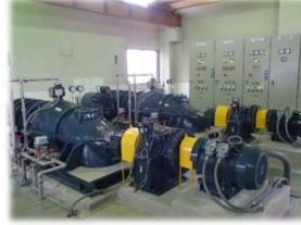
排水機場ポンプ更新（長野市松代町大室）
