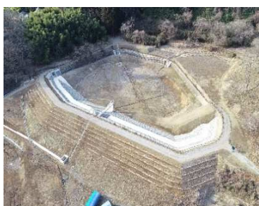
防災工事等を実施したため池（上田市西塩田地区 不動池）
