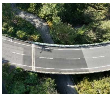
新唐沢橋 修繕工事
