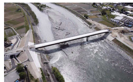
(主)伊那生田飯田線 松川町 宮ヶ瀬橋
