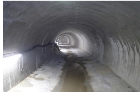
機能回復した水路トンネル
