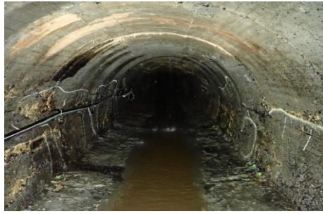
老朽化が進んでいた水路トンネル
