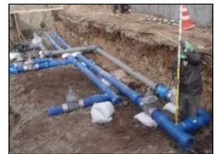
水道管の交換
