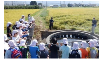
【農業用水探検隊の実施状況(西天竜円筒分水工)】
