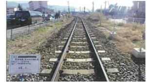
マクラギPC化(長野電鉄(株))
