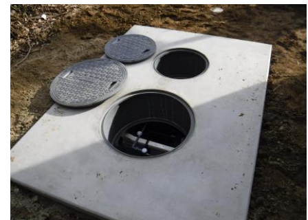
合併処理浄化槽の設置
