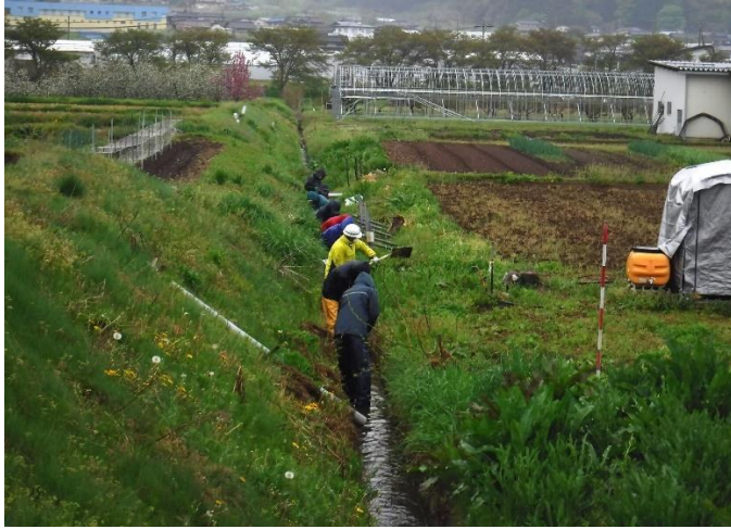
地域資源の基礎的な保全活動(水路の泥上げ)
