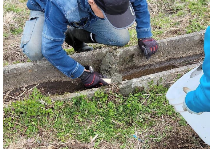
施設の長寿命化活動(水路の目地補修)
