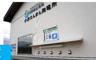
非常時に地域住民が利用可能なコンセント
