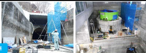
大規模改修中の発電所
