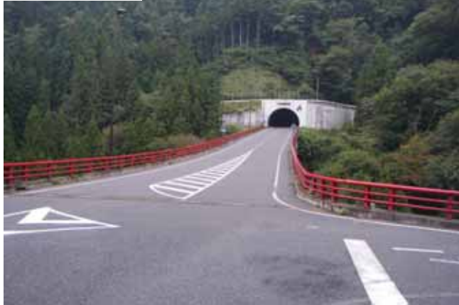
帯川トンネル
