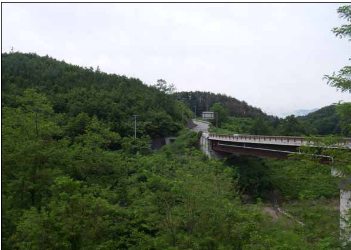
施工後(現況)写真
