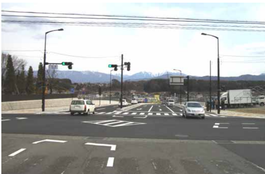
施工後(現況)写真
