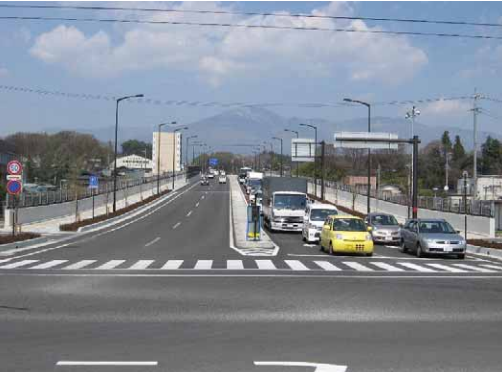
施工後(現況)写真
