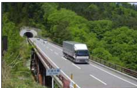
道路改築事業(阿南町) (国)151 号 落合～新野バイパス (バイパス化による地域活性化)
