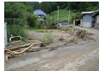
保全対象: 市道(平成29年8月豪雨により土砂が流出)
