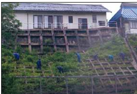
急傾斜地崩壊対策事業 高山村 牧北 (住民参加による草刈りの実施など適切な維持管理を実施)
