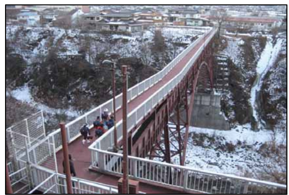
県営かんがい排水事業 伊那市 三峰川右岸 (水路橋上部の管理道路を生活道路(通学路)として有効活用)
