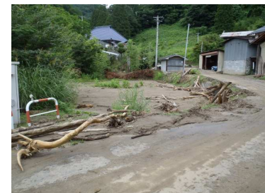
保全対象: 市道(平成29年8月豪雨により土砂が流出)
