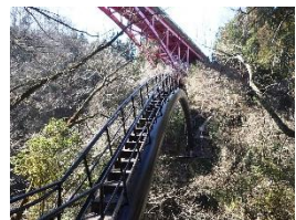
【竜東一貫水路の補修工事】
