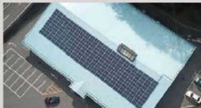
阿南ショッピングセンター 協業組合 ナビカ 阿南町西橋 / 出力49.5kw, CO 2 削減量 / 29,484kg-CO 2 /kwh
