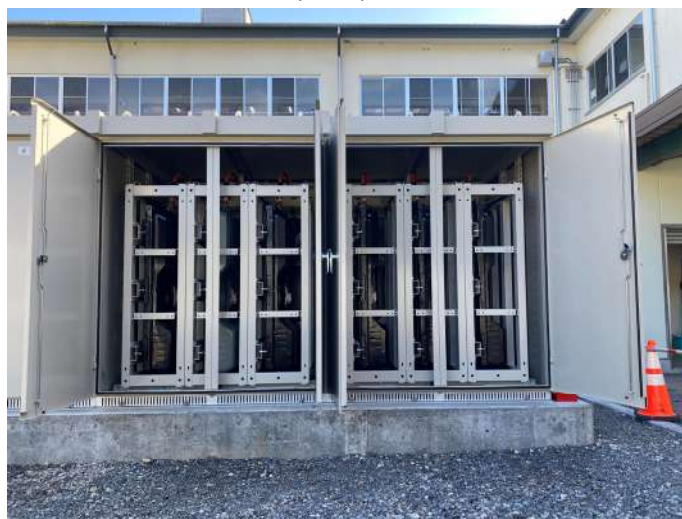
蓄電池システム : 日東工業製 サファLink-ONE 日産リーフのリユースバッテリー 6パック
