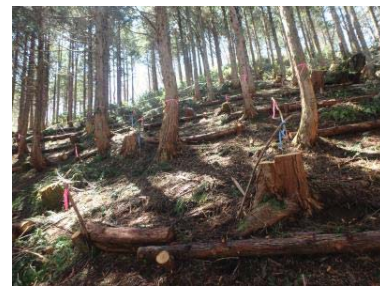
【本数調整伐と伐木筋工の一体的な施工事例】
