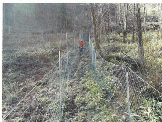
（写真－1）シカ防護柵 （左：金網柵、右：縦張柵）
