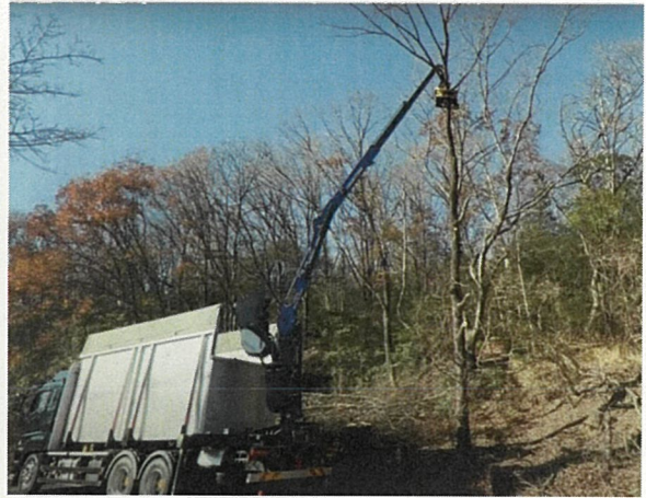
樹冠部の切断
