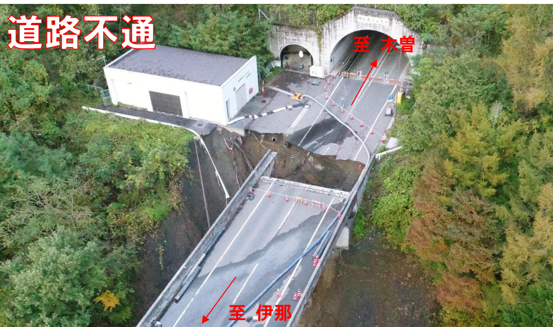
土砂流出により道路が崩壊
