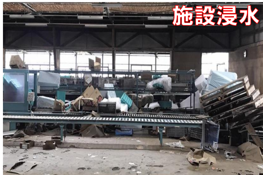
集出荷施設が浸水し稼働停止
