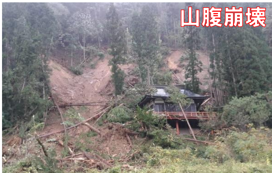
山腹崩壊により神社及び県道が被災
