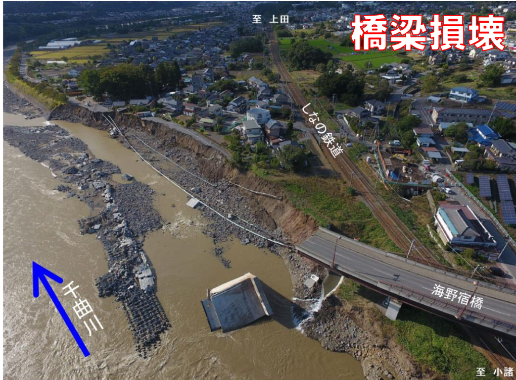
橋梁の流失により交通が寸断 ※河川②と同一箇所
