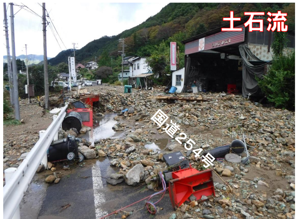
土石流が国道254号を寸断
