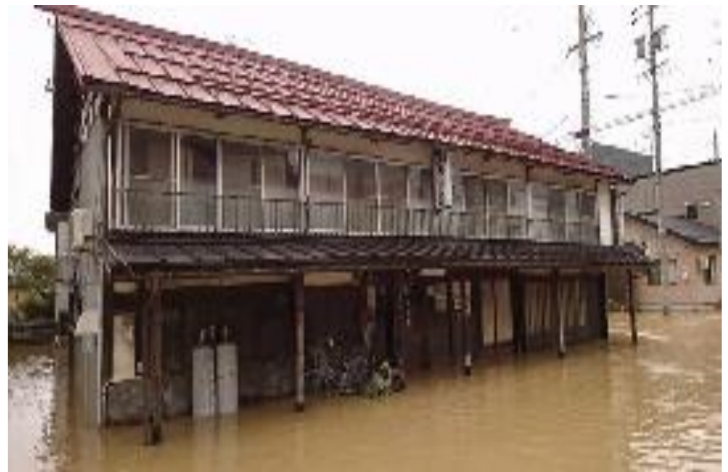
旅館浸水（外観）
