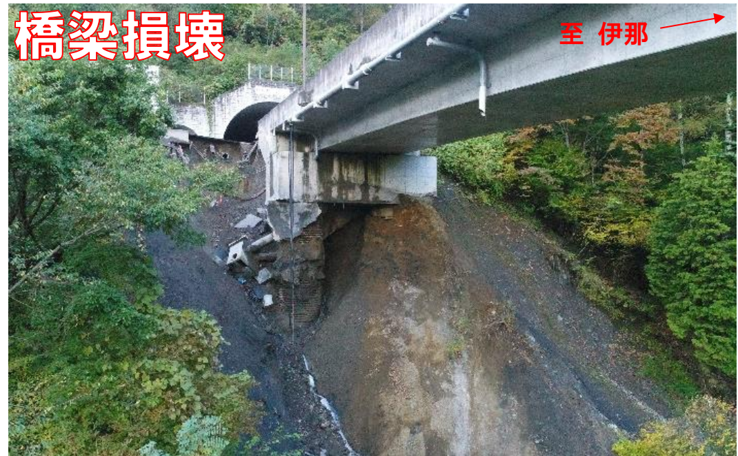
崩落により橋台基礎が露出し不安定化
