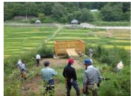
【遊歩道整備の様子】
