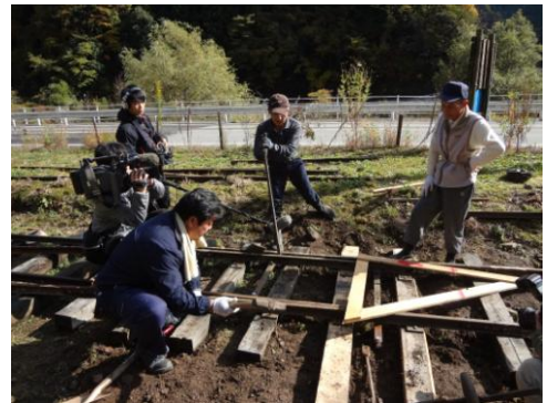
【レールの敷設作業】
