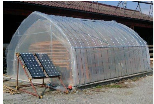
【木材乾燥施設（ビニールハウス）】
