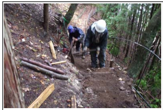
【遊歩道設置の作業の様子】
