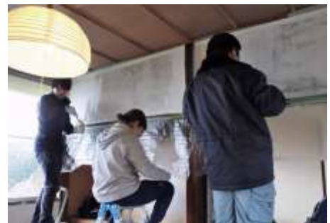
【改修作業の様子】
