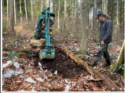
【重機による作業】
