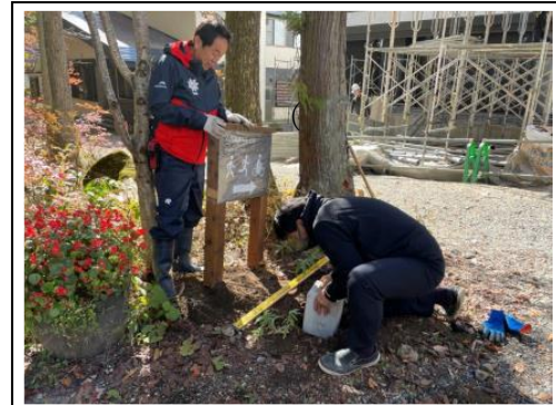
【看板設置作業】
