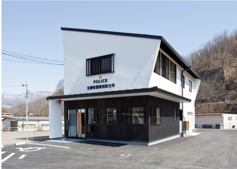
設計者：R-works（上田市） 施工者：株式会社栗木組（上田市）
