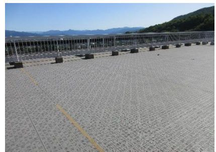
本館棟屋上階
