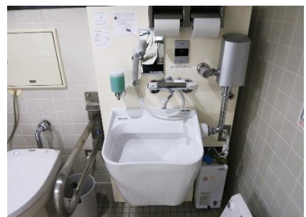
2階多目的トイレ
