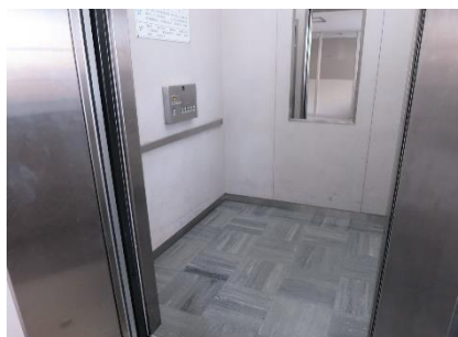
エレベーター内
