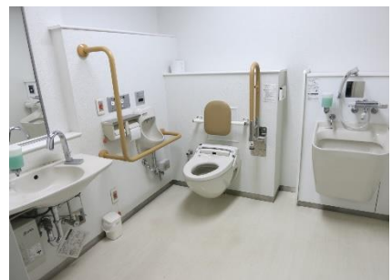
1階多目的トイレ
